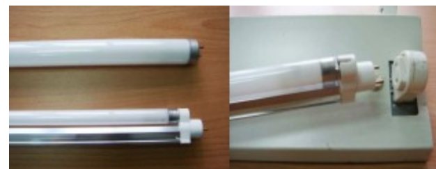
第六步驟-直接安裝T5節能燈具
