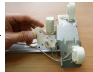
第三步驟-拆除啟動器
