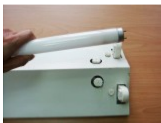
第一步驟-拆T8燈管
